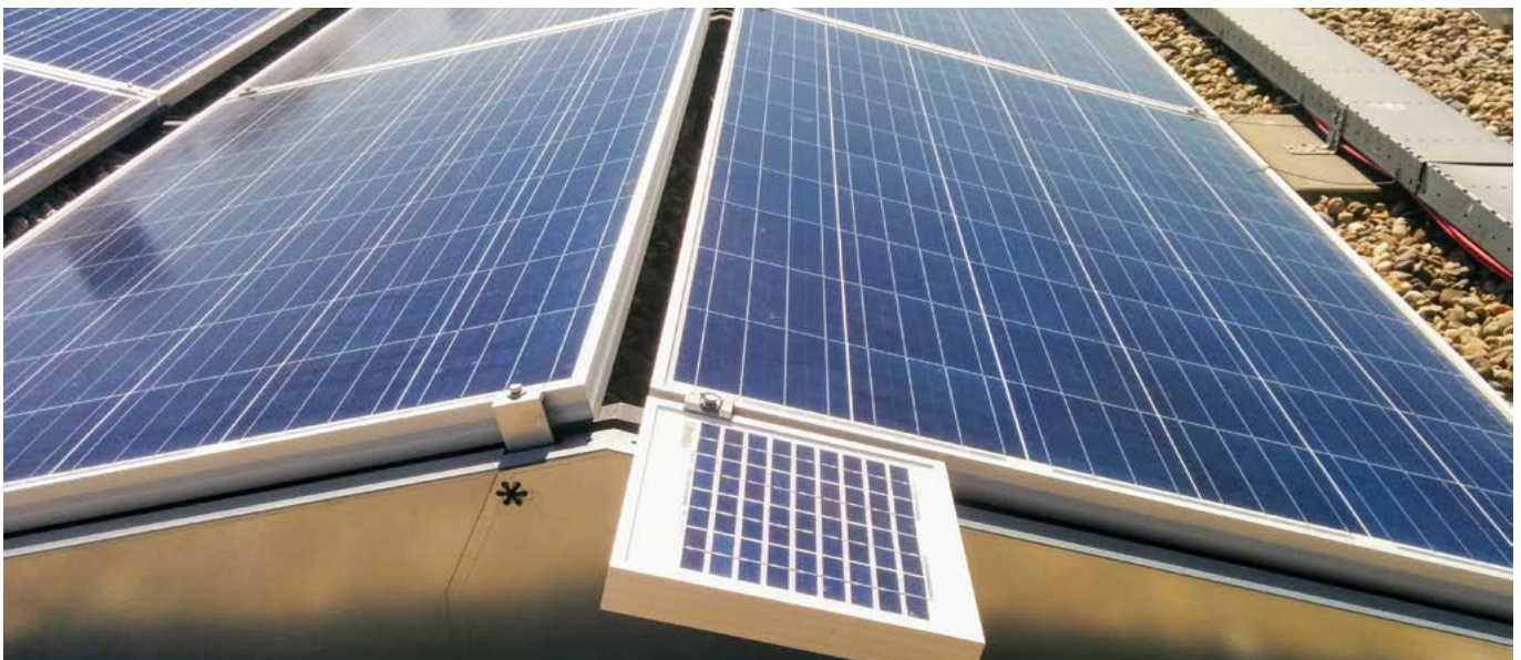
Figuur 3 Zonnepaneel met referentiecel voor instraling en temperatuur
